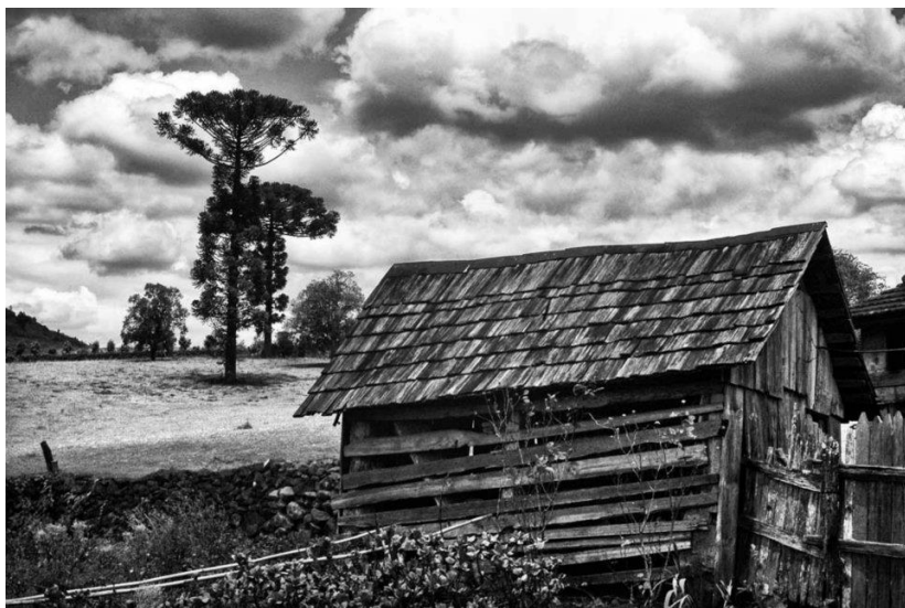
Antigo paiol com cobertura feita de tabuinhas. Áurea - RS. 29.01.2005.
