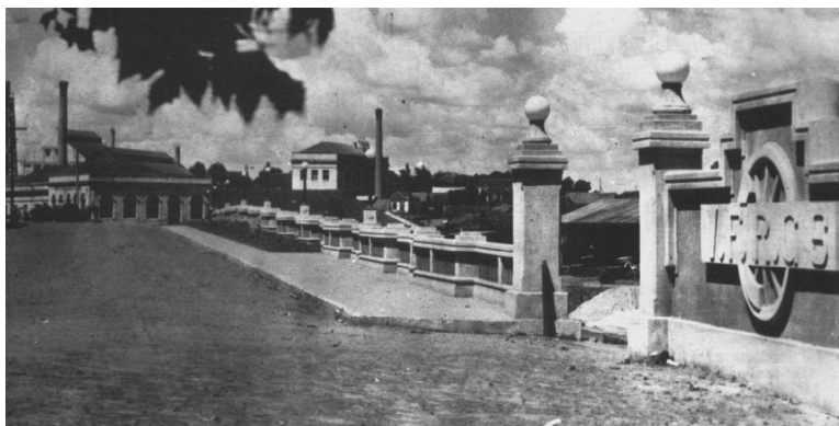
Figura 6. Muro e portão de acesso à Gare da RFFSA, inventariado para tombamento provisório.
