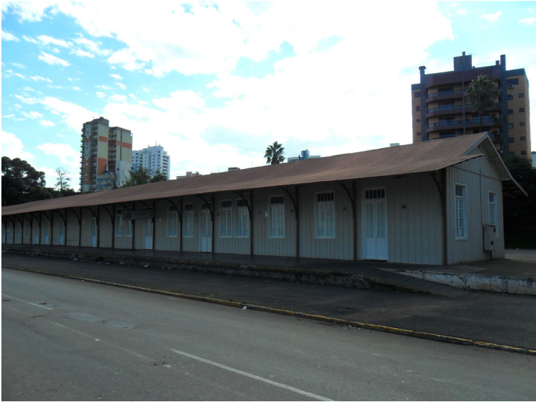
Figura 5. Estação Férrea da Gare.
