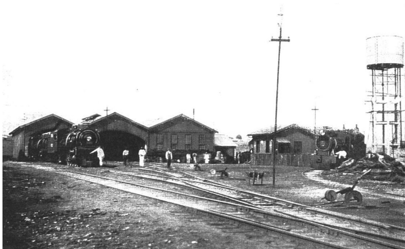
Figura 6. Vista do depósito de locomotivas de Passo Fundo, em 1927, localizado em frente à Estação Férrea. Ao lado a nova caixa d'água em estrutura metálica. Fonte: RELATÓRIO, 1927.
