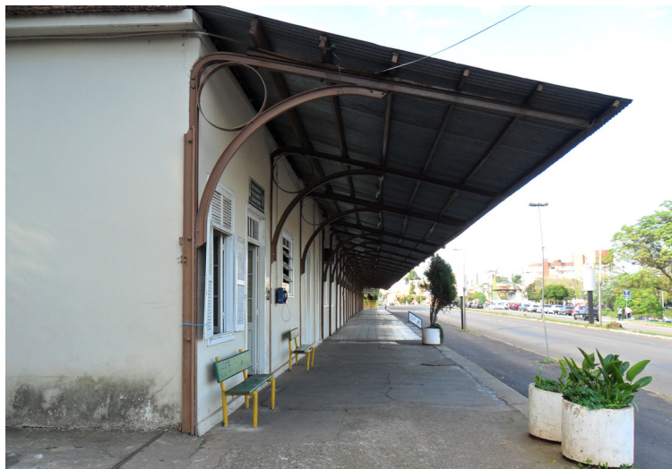
Figura 9. Estação Férrea da Gare.
