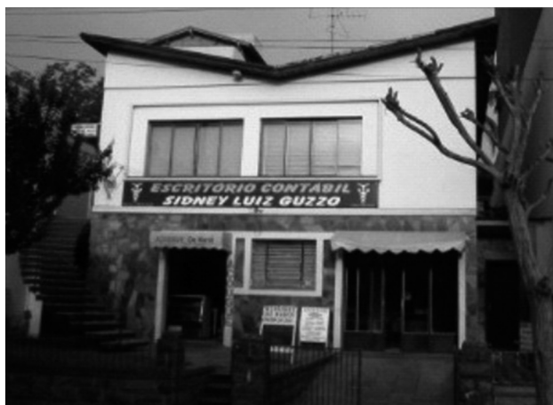
Figura 4. Residência Leonel Caliari, década de 60. Fonte: Costa et al., 2011.
