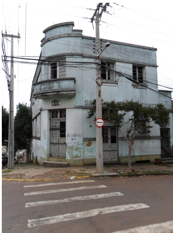
Figura 1. Prédio onde funcionava o Cassino da Maroca.
