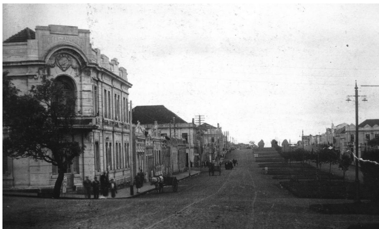
Figura 5. Avenida Brasil: aspecto em 1934.
