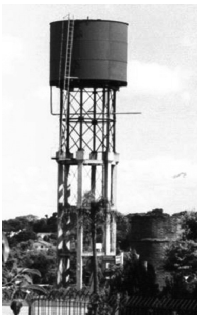
Figura 3. Reservatório de Passo Fundo.
