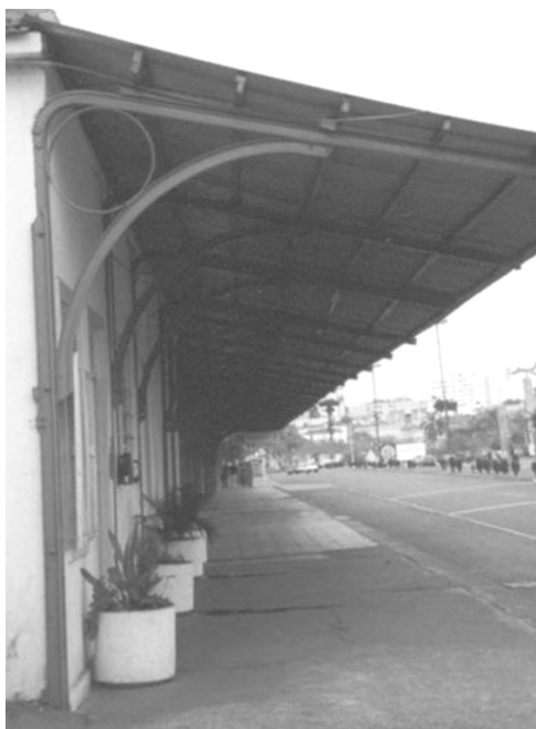
Figura 2. Marquise da plataforma de embarque. Mãos francesas metálicas.
