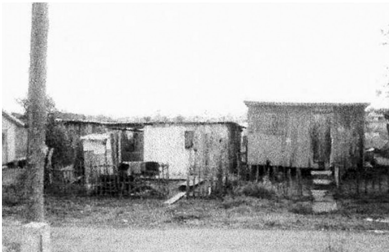
Aspecto do bairro em 1985 (Arquivo da Associação de Moradores do bairro Zachia).
