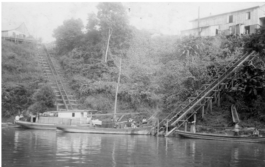
Carga e descarga de pequenas embarcações no rio Taquari em Muçum - O sistema de trapiche funciona com contrapesos, colocando-se a carga embaixo e um peso em cima. Fonte: Museu de Muçum.
