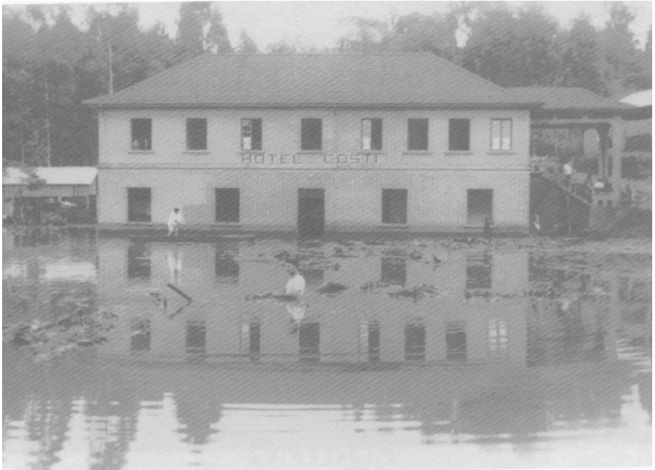
Hotel De Costi, em Encantado, na ocasião de uma enchente. Fonte: Hugo Peretti.
